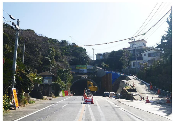
②坂下トンネルの施工状況（H28.2現在）
