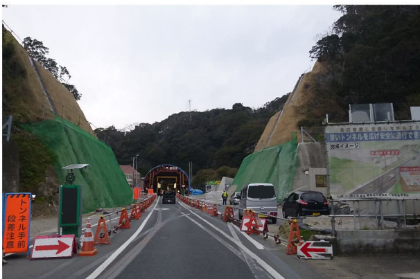
①久保トンネルの施工状況（H28.2現在）
