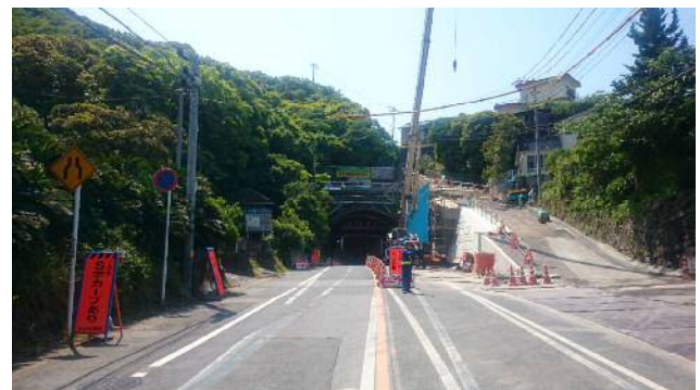
②坂下トンネルの施工状況（H28. 5現在）
