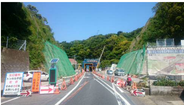
①久保トンネルの施工状況（H28. 5現在）
