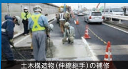
土木構造物(伸縮継手)の補修
