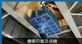
橋梁の接近点検
